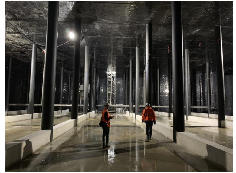
Bassin de sécurité Lagrua La Teste 2019
