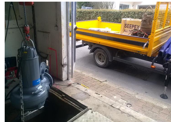
Renouvellement de pompes
