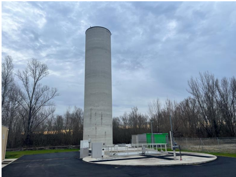
Cheminée d'équilibre et poste de pompage ZI Facture Biganos 2022/2023
