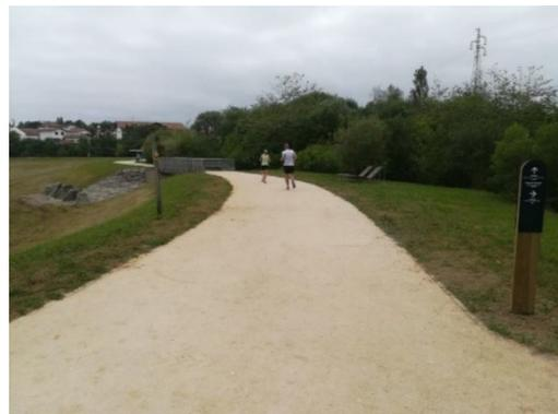
Revêtements à base de béton bas carbone à Port d'Albret à Soustons (image de gauche), et stabilisé avec liant pouzzolanique sur la Voie verte de l'Uhabia à Bidart (image de droite)
