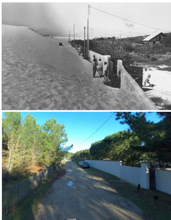
Figure 2-1 : La rue des Bernaches du secteur des "ensablés", en haut en 1989 (source : Annie Peyras / Archives Sud Ouest) avant les travaux de l'ONF, et en bas en 2020 (source : Google). Le sable a été dégagé de la route et des habitations, et le revers interne de la dune a été remodelé et stabilisé par la plantation de végétation.
