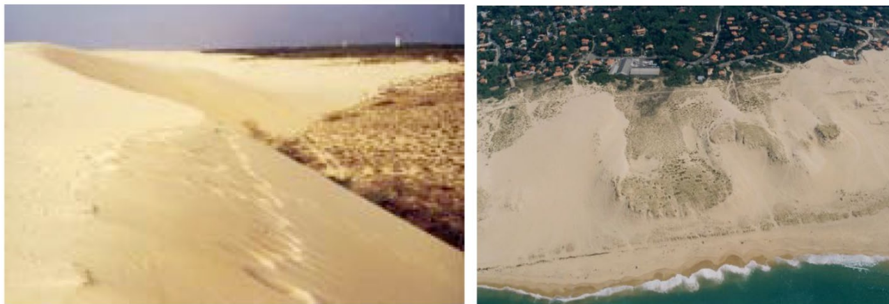
Figure 2-9 : Photographies du cordon transgressif de la dune dans le secteur des « ensablés » avant réhabilitation en 1988 (à gauche), et de la dune avançant dans le quartier des « ensablés » en 1994 (à droite) (Favennec et al., 2018, extrait de BRGM).
