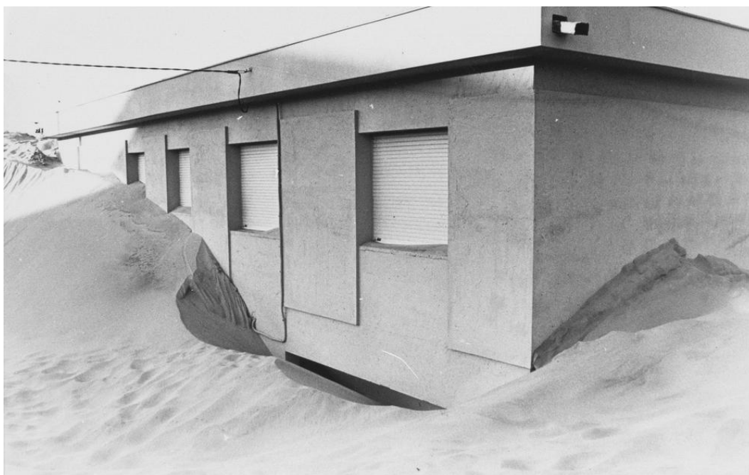
Figure 2-4 : L'entrée du garage de cette maison est obstruée par le sable à La Pointe du Cap Ferret, photographie prise le 22 février 1988 (Source : Romain Peyras / Archives Sud Ouest).
