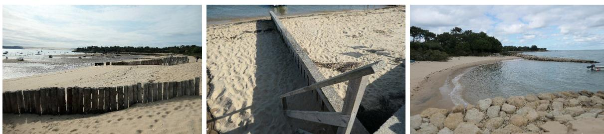
**Figure 2-9 : Exemples d'ouvrages perpendiculaires au trait de côte présents sur la façade interne du Cap Ferret dans le bassin d'Arcachon (A-Mimbeau, B-Piraillan, C-La Pointe) (clichés Créocéan, 2020).**
