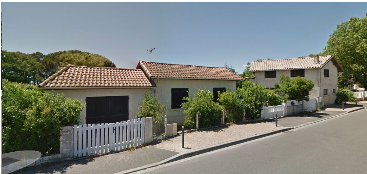
Logements communaux proche de l'école du Bourg de Lège
