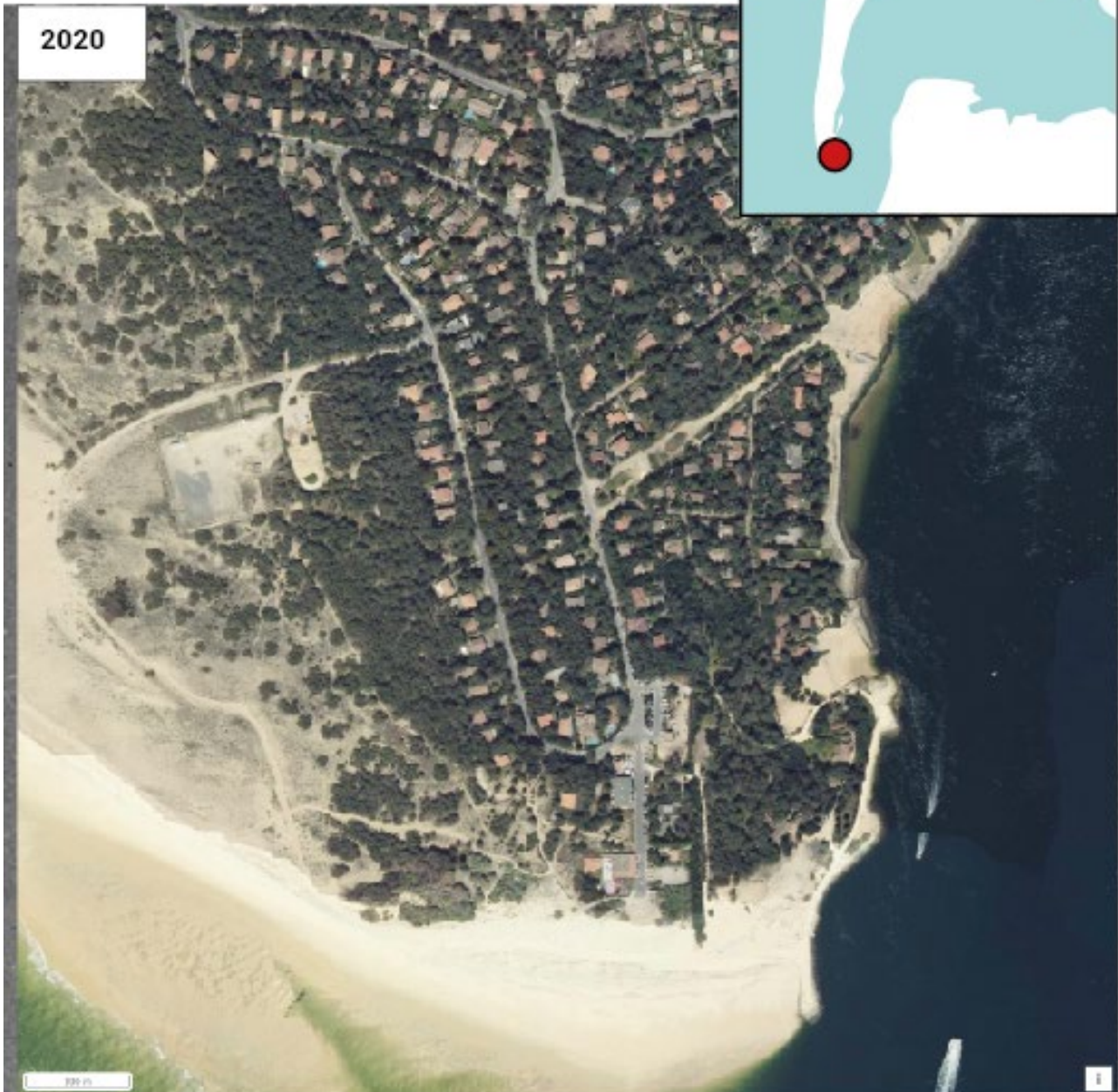
Développement de l'urbanisation au plus près du rivage et sur l'ensemble de la pointe. A noter l'érosion de la pointe du Cap Ferret
