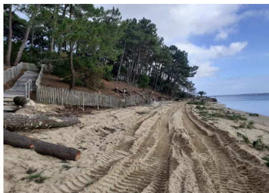
Sécurisation de la plage du Truquet
