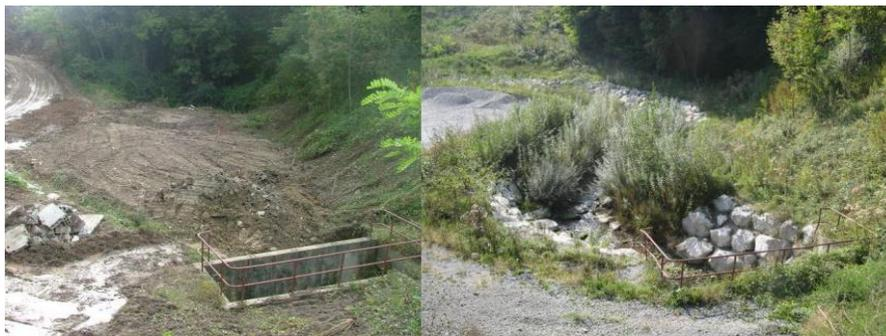
Ci-dessus, l'aménagement d'une passe à poisson à Chatel-Chéhéry, dans les Ardennes. Ici, le système dit à « montaison », permet aux poissons migrateurs de franchir des obstacles, en les attirant à l'aval de la passe et en les incitant à circuler vers l'amont.
